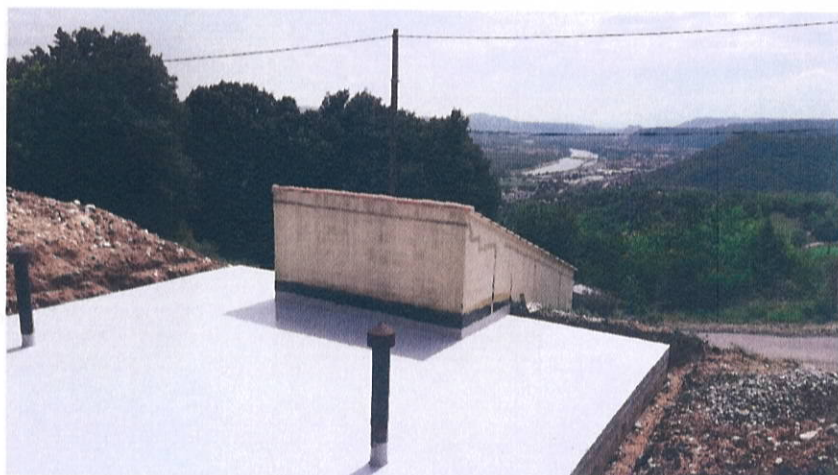
Etanchéité sur cuve réservoir la Blache Rochemaure
