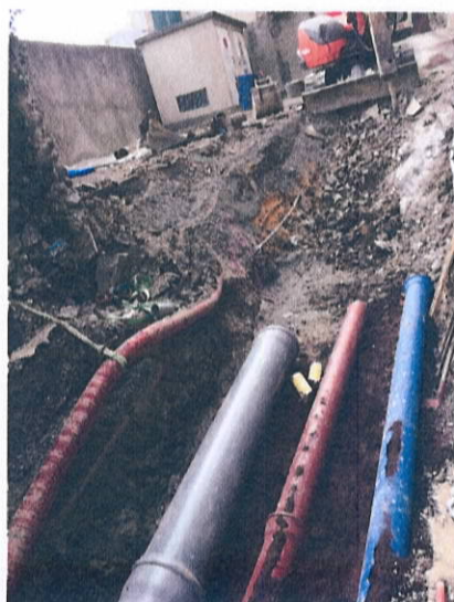
CHOMERAC – Renouvellement réseaux
