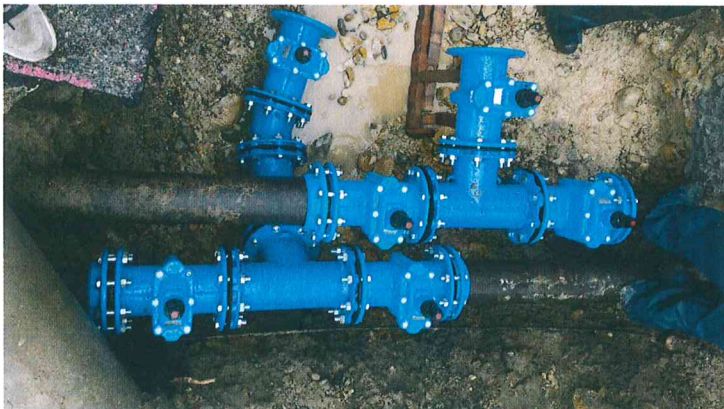
Chantier Cruas Meysse (Mars 2018)
